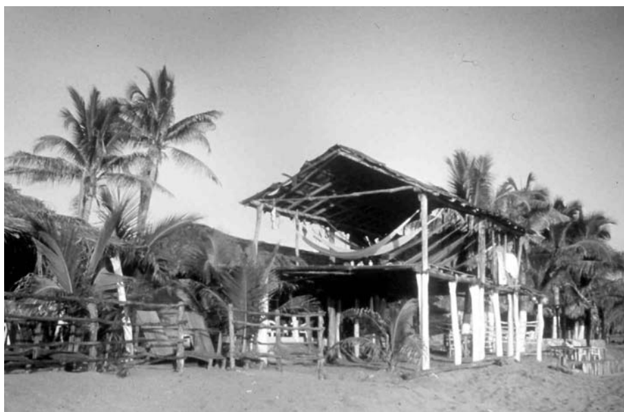
Bild 1 Eine einfache Schutzkonstruktion im tropisch-feuchtwarmen Küstenklima Mexicos mit maximaler Durchlüftung und Hängematten zur Ausnutzung der Luftbewegungen, welche eine Wärmeabgabe des menschlichen Körpers über Hautoberflächen-Verdunstung erleichtern
