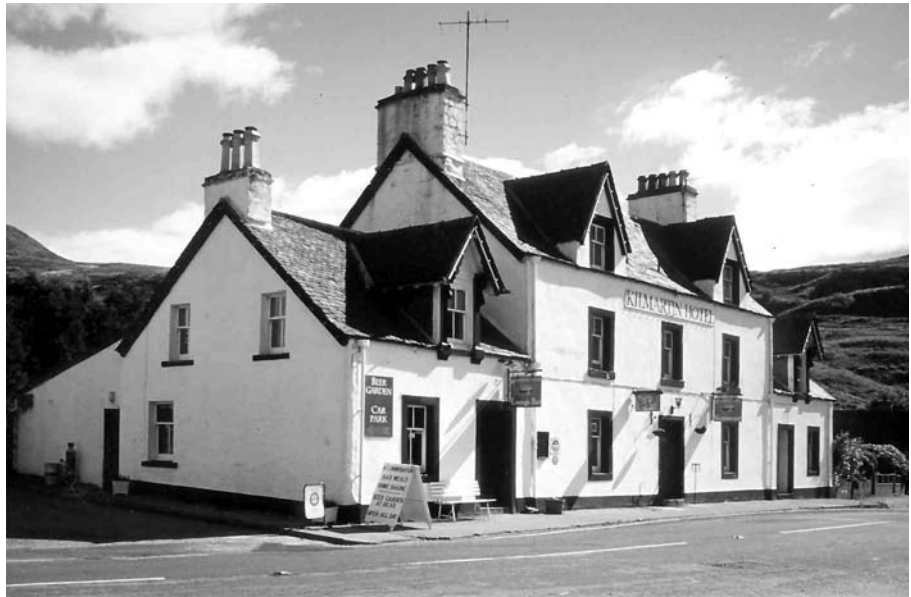
Bild 63 Ein Gasthof in Schottland mit heruntergezogener Nordseite und hoher Südfassade sowie größeren Fenstern zur Nutzung der Wintersonne
