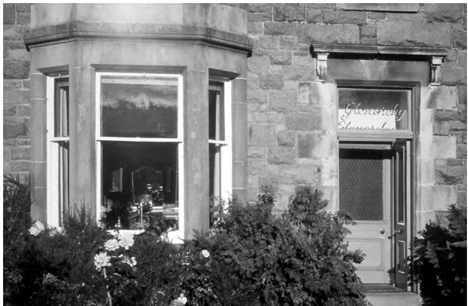
Bild 64 Fassadendetail aus Schottland mit Sonnenerker und hausintegriertem Windfang
